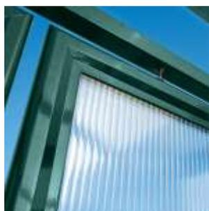
Bardage latéral en polycarbonate alvéolaire ép 10mm
