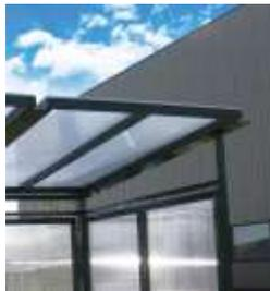
Toiture en panneaux de polycarbonate alvéolaire ép 10mm
